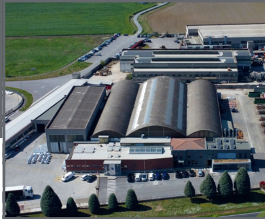
Am Stammsitz in Casalbuttano entstehen individuelle Förderlösungen für Kunden weltweit
